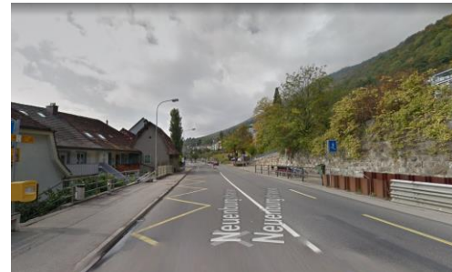
Rue de Neuchâtel section centre
