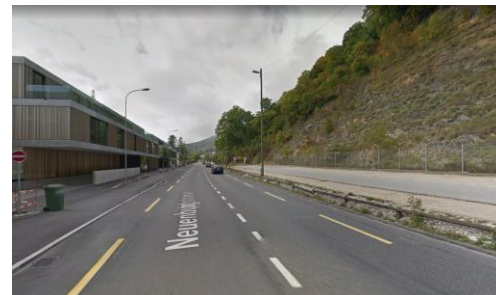
Rue de Neuchâtel section centre
