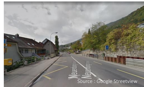
Rue de Neuchâtel section centre
